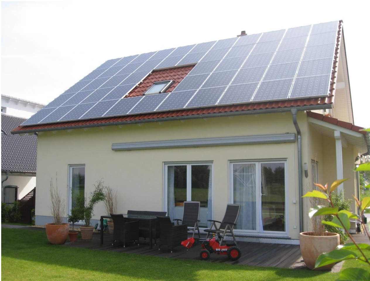
Foto: Taunus Solarenergie GmbH Einfamilienhaus Bad Vilbel
