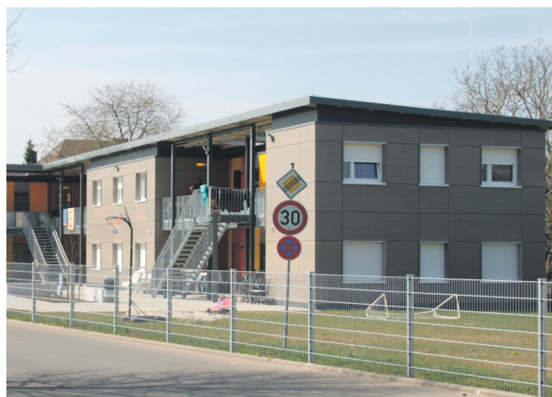
Das bereits fertig gestellte Asylbewerberheim in Kriftel. Die Schwalbacher Unterkünfte werden ähnlich aussehen.
