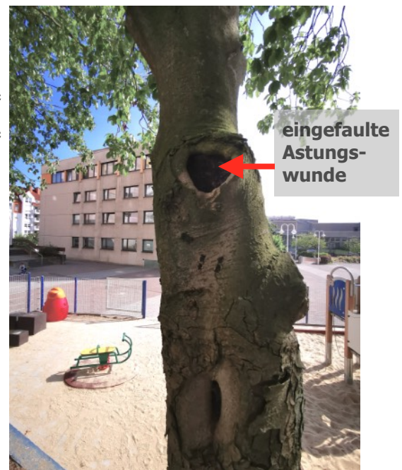
Bild 3: Stammkopf von Baum Nr. 56 mit eingefaulten Astungswunden. Die Holzfäule ist derzeit begrenzt und breitet sich nicht weiter aus.
